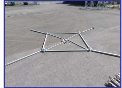
Assemblez les sablières (repère F) par emboîtement sur les crochets d'angle (repère D), pour former un cadre fermé, en vous assurant du bon verrouillage des cliquets.
