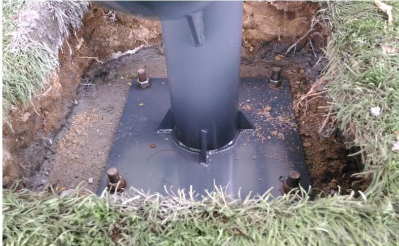
Retirer les écrous et rondelles de la platine de fixation. Placer le module sportif en faisant se superposer les platines, et le fixer au sol avec les écrous et rondelles préalablement retirés.
