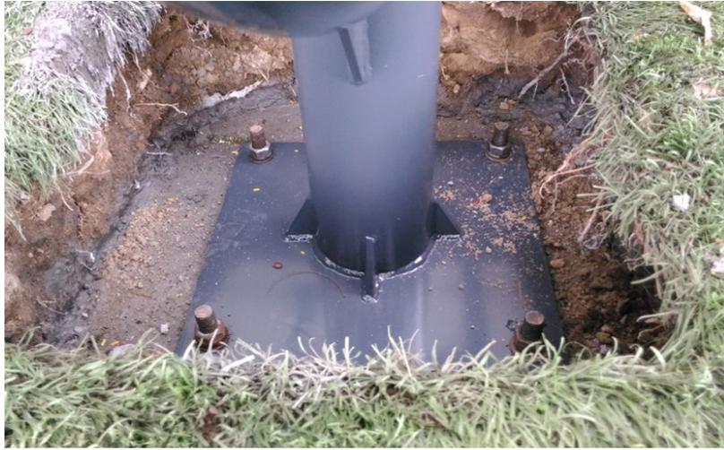
Retirer les écrous et rondelles des platines de fixation. Placer le module sportif en faisant se superposer les platines, et le fixer au sol avec les écrous et rondelles préalablement retirés.
